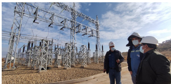
Inspección Subestación La Angostura, Tarija
