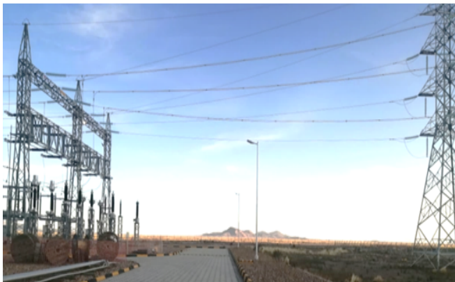
Vista del Proyecto: Adecuación Segunda Terna Línea Pagador – Solar Oruro en 115 kV
