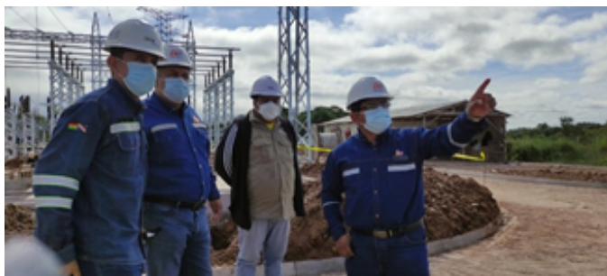
Inspección a la instalación de Sistemas de Distribución en la Subestación Bermejo
